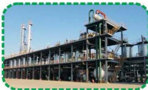
开发的3万吨/年稀土异戊橡胶生产装置
